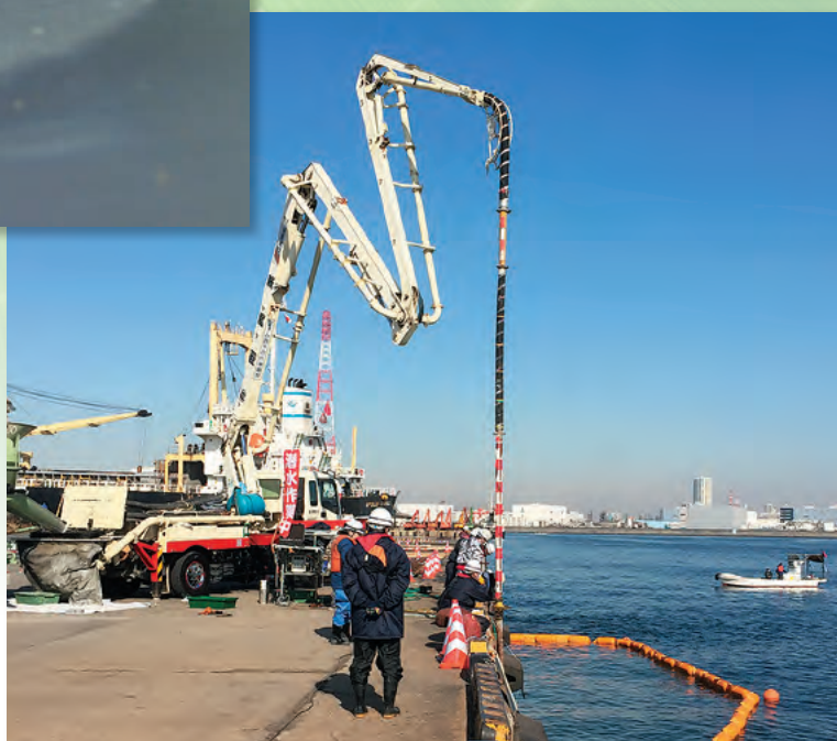
港湾構造物打設測定状況（写真提供：株式会社ダイトー）
